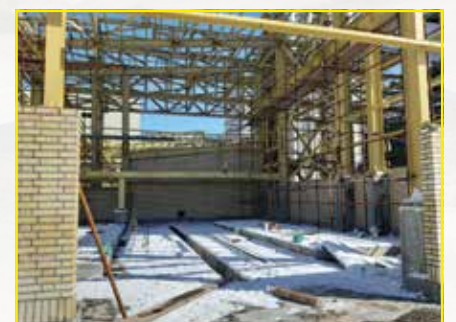
فونداسیون تجهیزات BFP شماره ۲
