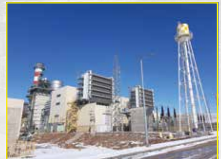
نمایی از ضلع شرقی واحد های گازی
