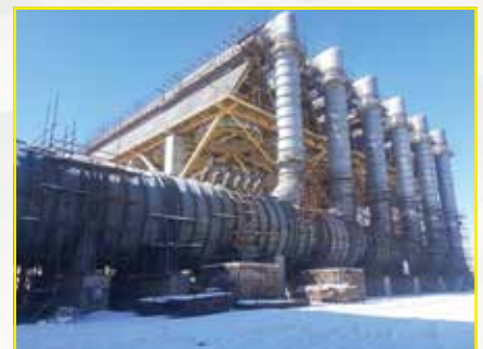
نمایی از Steam Duct سیستم ACC
