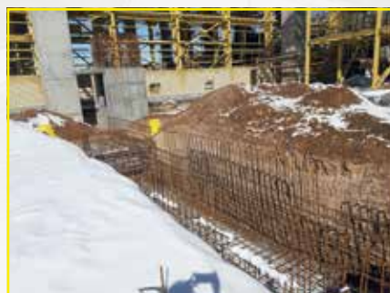
آرماتوربندی کانالهای جمع آوری آبهای سطحی بخش بخار
