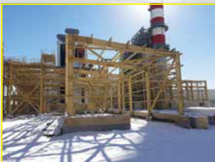
نمایی از کفسازی ساختمان CDP
