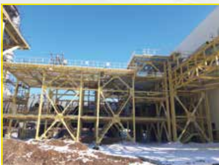
عملیات Piping روی استراکچر فلزی ضلع غربی بخش بخار
